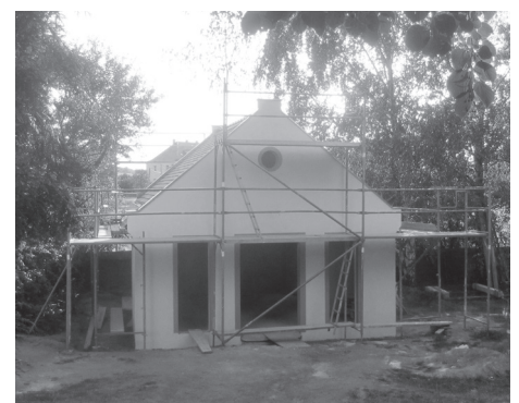
Baustelle der neuen Trauerhalle Reichenberg
